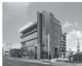
大和エネルギー株式会社 オフィスビル「EneLF7」
