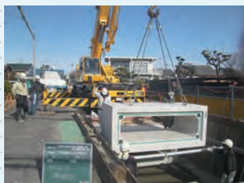
ボックスカルバート敷設工事
