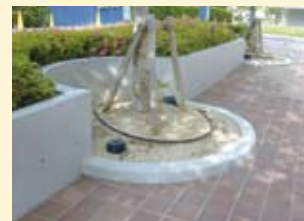
雨水散水設備
