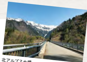
北アルプス大橋
