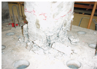
実験終了後の柱基部
