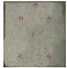
写真-2 ひび割れを導入した試験体
