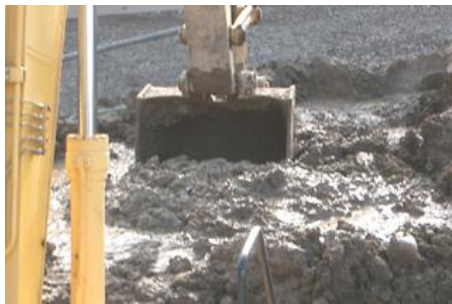
写真-1 地盤改良時の発生土 1)
