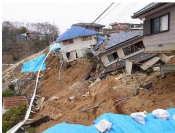
写真-1 造成地での被害状況 1)
