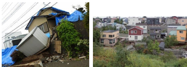
写真.1 液状化被害状況 写真.2 北海道胆振東部地震
