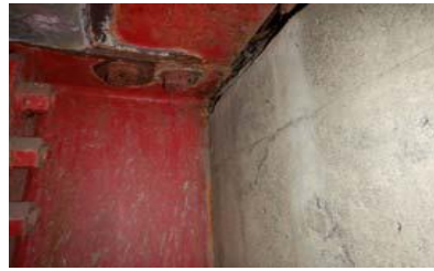
写真-1 A1上流側の主桁と パラペットの密着
