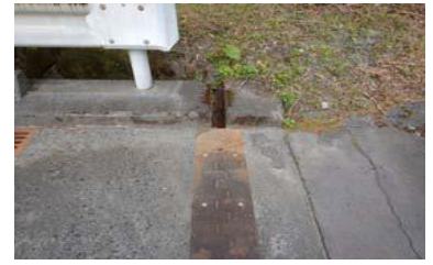
写真-2 A1伸縮装置の密着
