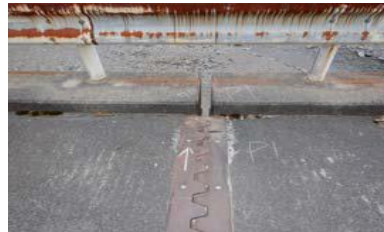
写真-3 橋の中間地点の伸縮装置 (上流側)
