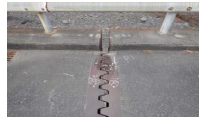
写真-4 橋の中間地点の伸縮装置 (下流側)
