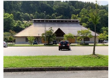
図-6 桜の郷荘川の敷地内の屋内運動場
