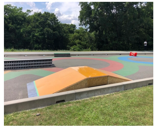
写真10 セクション完成
