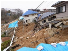
写真-1 液状化による住宅被害
