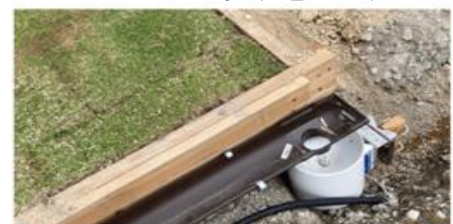
図 2-3 雨樋を用いた現場流出試験
