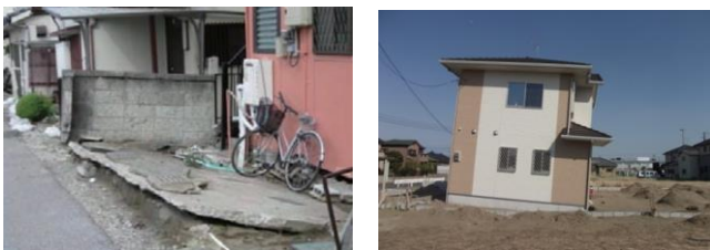
(a) 建物被害 (b) 建物被害
