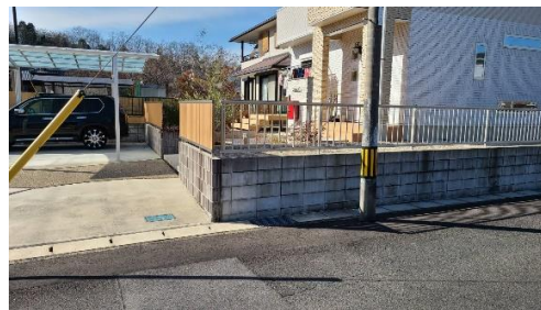
写真3 嵩上げされた住宅
