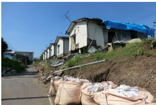
写真 1 熊本県益城市での宅地被害
