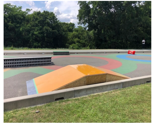
写真10 セクション完成
