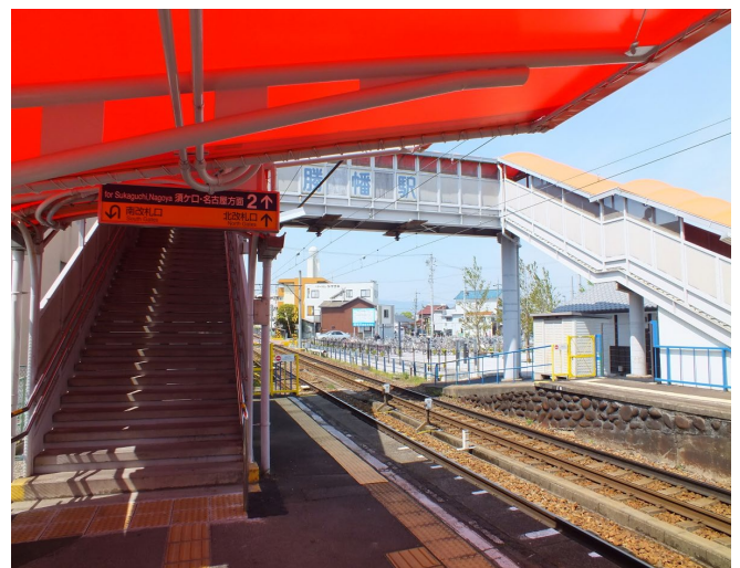
図4 勝幡駅の跨線橋
