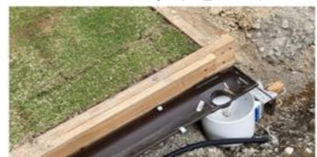
図 2-3 雨樋を用いた現場流出試験
