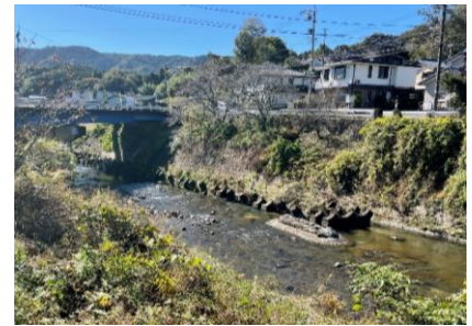
写真3 湾曲部外岸側のブロック
