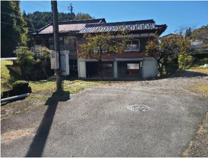
写真2 ピロティ式の住宅（小里川）
