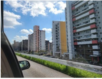
写真1 堤防付近の高層建築物（矢田川）
