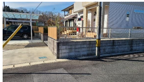
写真3 嵩上げされた住宅
