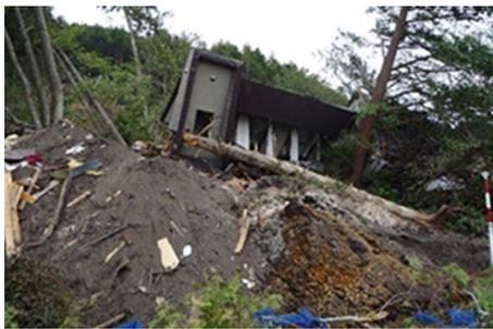
写真-1 胆振東部地震での斜面崩落
