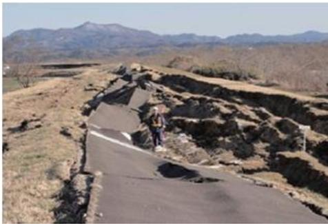
図 1 液状化現象によって陥没した堤体
