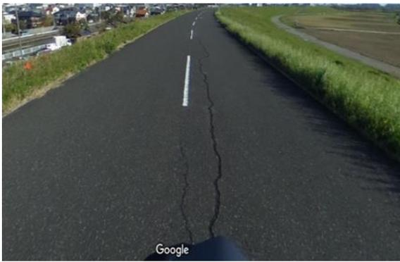
図3. 図2の地点における縦断亀裂
