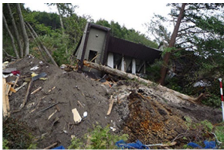
写真-1 胆振東部地震での斜面崩落
