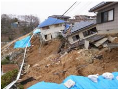
写真-1 住宅被害 (福島市)
