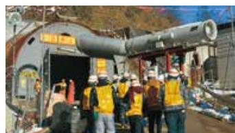
高速道路 施工現場見学
