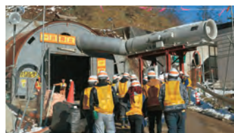
高速道路 施工現場見学
