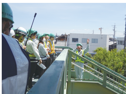
名古屋高速道路小牧線の橋梁補修 工事現場視察
