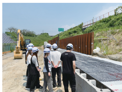
知多半島道路のパーキングエリア 施工現場の視察
