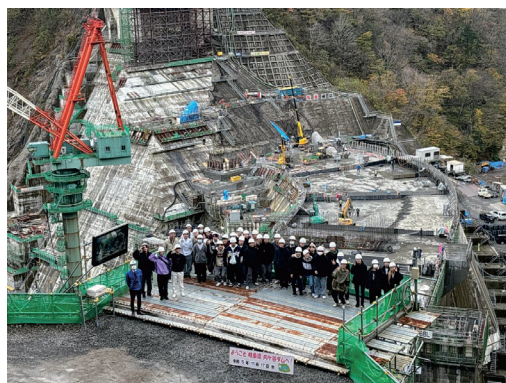
岐阜県郡上市、内ヶ谷ダム本体工事の見学
