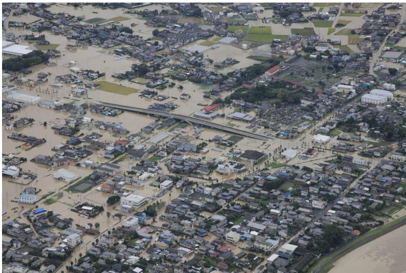
2015/09 鬼怒川の破堤による浸水
