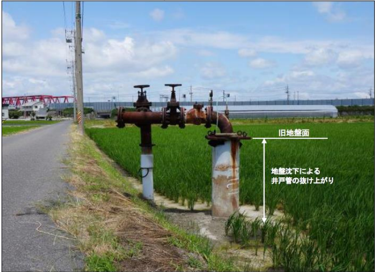
三重県桑名郡木曽岬町の井戸の抜け上がり状況(平成26年6月撮影) ※ 近傍の水準点(C35-9)における累積沈下量: 116cm(昭和36年～平成25年)
