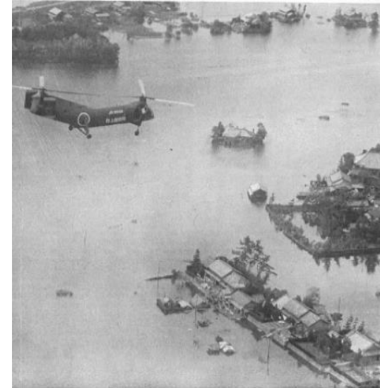
水中に孤立した盛土上の家屋(旧長島町)
