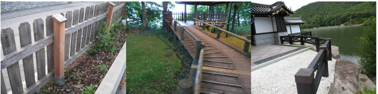
写真1 小口を保護した木製フェンス（オーストリア）
