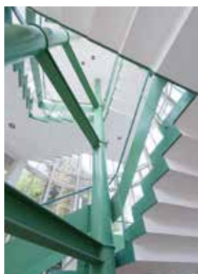
21号館階段 建築設計：株式会社第一工房 (代表 高橋誠一)
