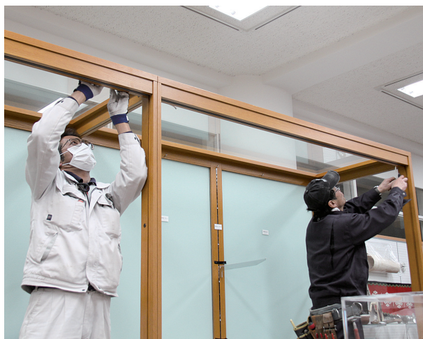
LED照明へへの入替工事の様子
