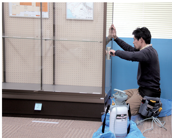
展示ケースフィルム工事の様子
